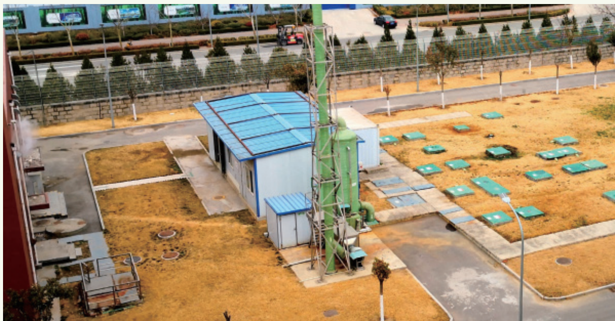
正大製藥（青島）污水處理設施
